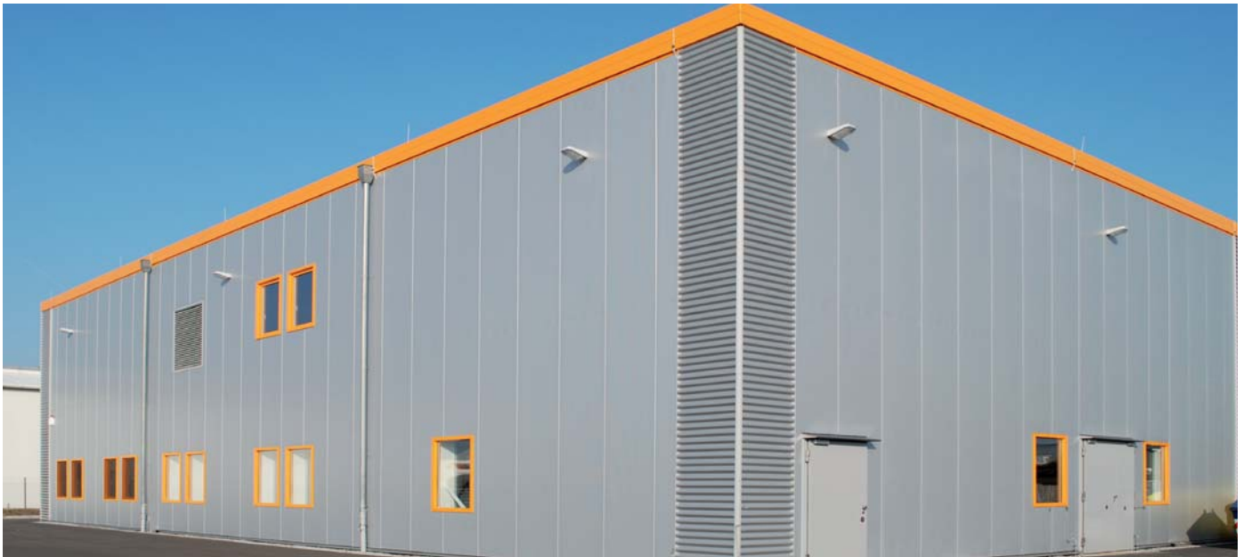
Das neue Impfstoffwerk – ein Zweckbau, der es aber in sich hat
