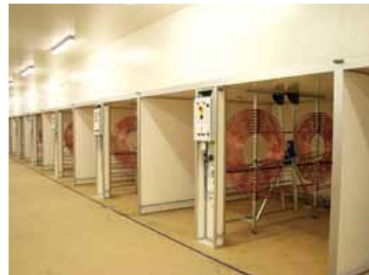
De koperen waterbuizen in de voorbroeders voor koelen van broedeieren zijn dikker dan normaal
